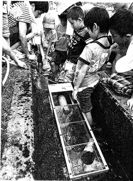
用水路に発電機を設置する小学生ら＝福井市中手町
